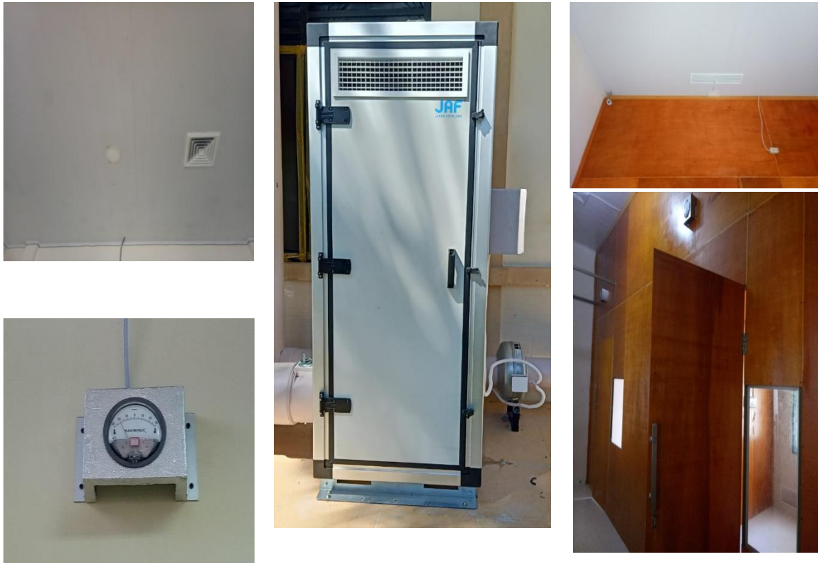
GAMBAR 9 Dokumentasi Pembangunan/Rehab Ruang Isolasi Tekanan Negatif (RITN)
